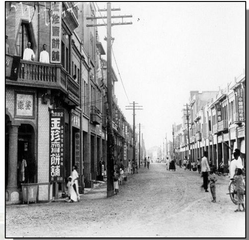
拆除後 不見天街
