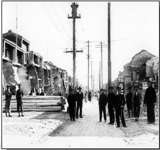
拆除中 不見天街
