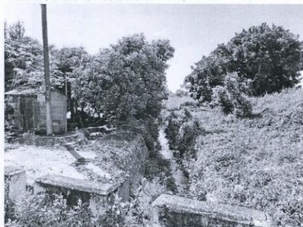
豐田村排水溝現況
