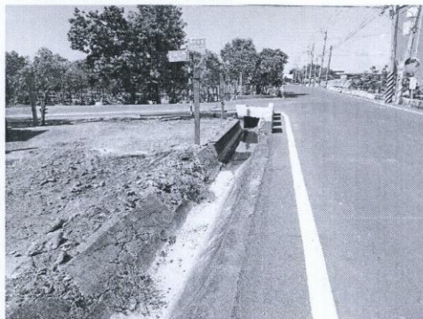
溪頂村給水溝現況
